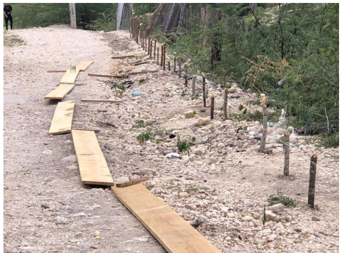
Construcción de Contenes C/Las Mercedes Alto Velo
