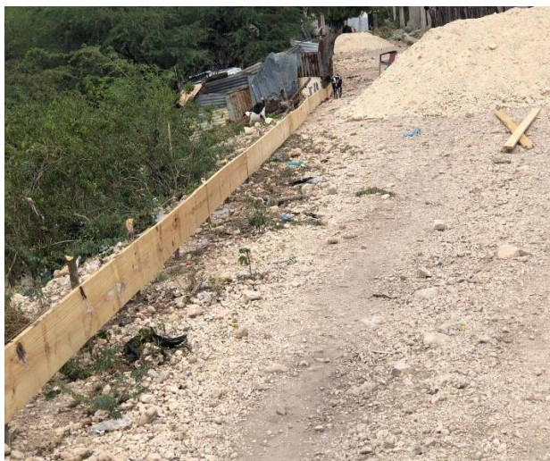
Construcción de Contenes C/Las Mercedes Alto Velo
