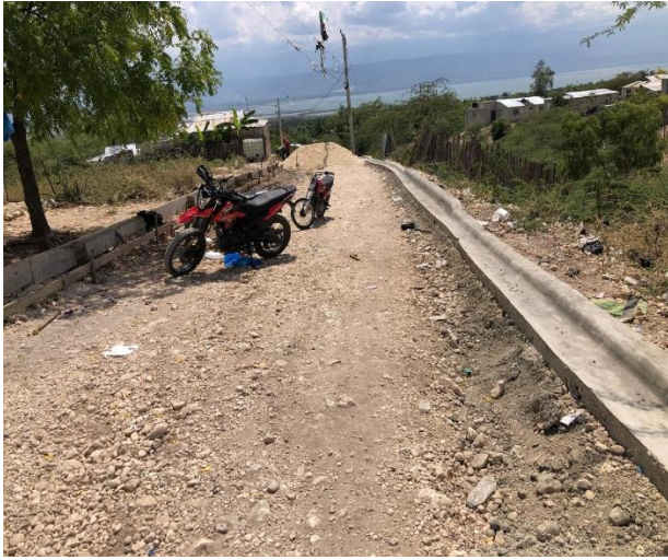
Construcción de Contenes C/Las Mercedes Alto Velo
